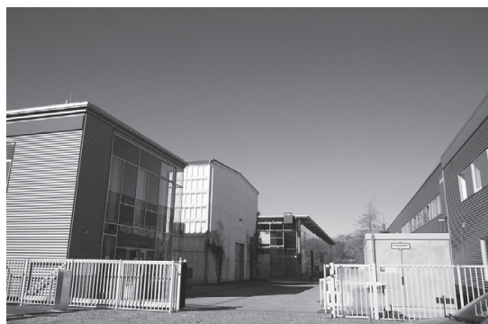
写真1 ゴータ工場テクノロジーセンターのエントランス
